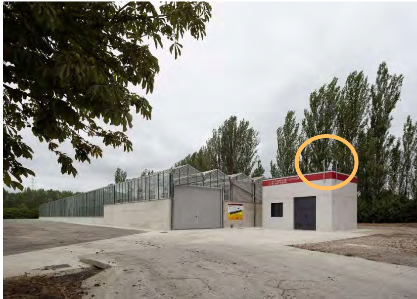
Vista General Instalación
